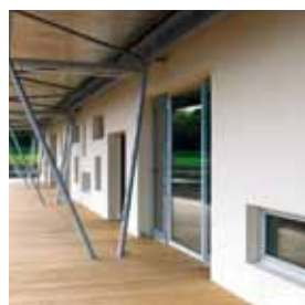
Bei Kindergärten ist die Planung und Umsetzung von Passivhaus-Standards besonders herausfordernd, wie z. B. beim Kindergarten in Ziersdorf (NÖ).
