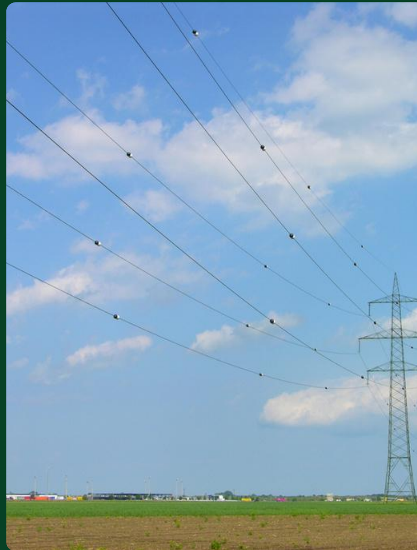
Markierung von Hochspannungs- leitungen in Österreich
