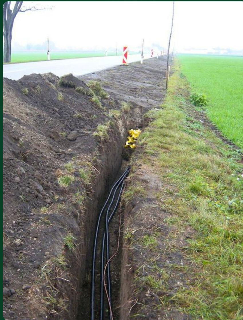
Erdverkabelung von Stromleitungen
