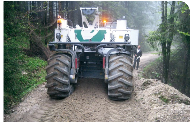
Eine von vielen Einsatzmöglichkeiten der Holzasche: Bodenstabilisierung im Straßenbau
