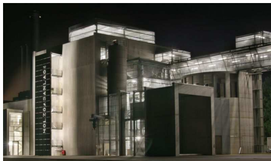
Abb. 1: Das Kraftwerk in Senden, nahe Ulm, Deutschland – eine industrielle Biomassevergassung mittels Zweibettwirlschicht (Foto: BIOENERGY 2020+)
