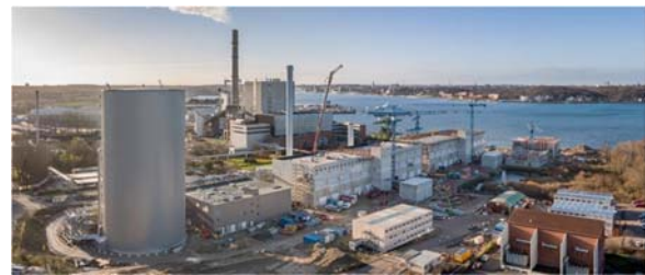
Küstenkraftwerk K.I.E.L.: 60 Meter hoher Wärmespeicher, daran anschließend die Motorenhallen (© Stadtwerke Kiel AG)
