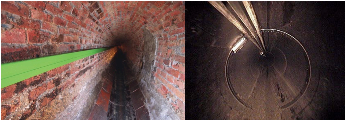
Abbildung 39: LWL-Verlegung im Abwasserkanal (metallfrei und metallisch)
