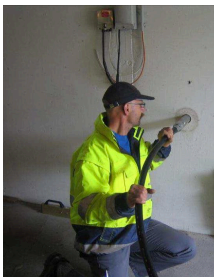
Abbildung 41: Ansetzen einer Erdrakete im Keller
