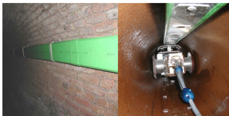
Abbildung 39: Verlegesystem mit Kabelkanal
