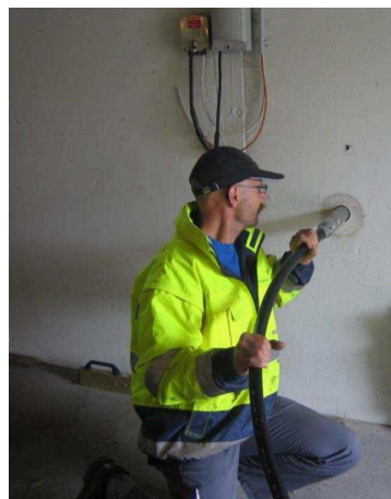
Abbildung 43: Ansetzen einer Erdrakete im Keller
