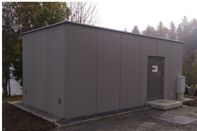
Abbildung 13: Ortszentrale in Fertigbeton-Bauweise
