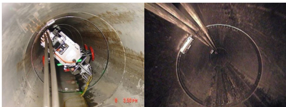
Abbildung 40: LWL-Verlegung im Abwasserkanal mit Spannringen
