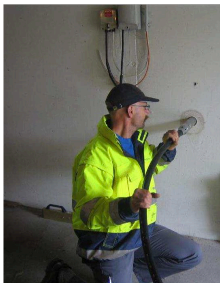
Abbildung 41: Ansetzen einer Erdrakete im Keller
