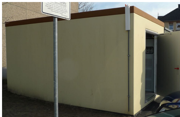
Abbildung 13: Ortszentrale in einem Container
