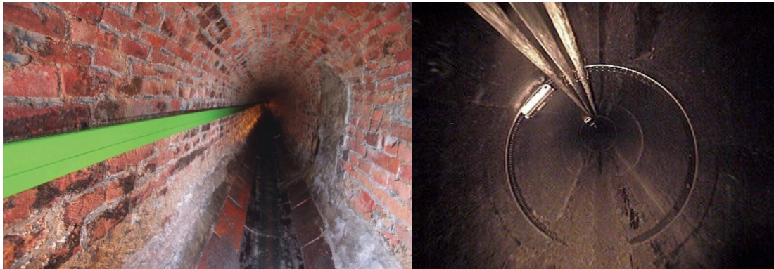
Abbildung 39: LWL-Verlegung im Abwasserkanal (metallfrei und metallisch)
