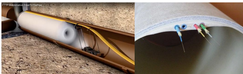
Abbildung 41: LWL-Verlegung durch Aufkleben eines Filzstreifens
