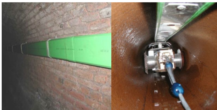
Abbildung 39: Verlegesystem mit Kabelkanal
