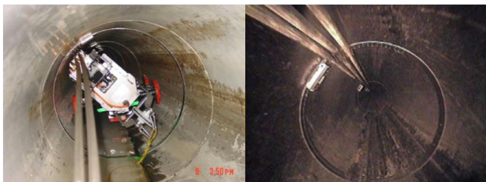
Abbildung 40: LWL-Verlegung im Abwasserkanal mit Spannringen
