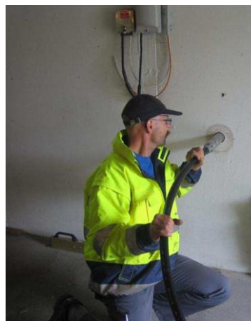
Abbildung 43: Ansetzen einer Erdrakete im Keller
