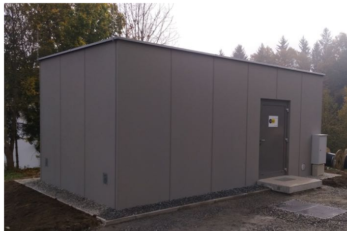
Abbildung 13: Ortszentrale in Fertigbeton-Bauweise
